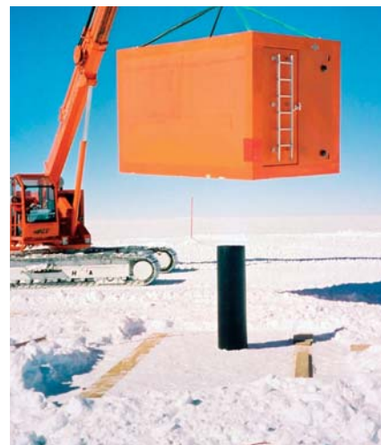
Figures 5a, b, c. Photos illustrant le remplacement du pilier de mesures absolues au cours de la campagne 2003-2004. L'ancien pilier, en bois, trop instable à cause du dessèchement du bois, a été remplacé par un pilier en polyéthylène enfoncé de 2,60m dans la glace. Trois étapes du remplacement sont illustrées : a) arrachement de l'ancien pilier, après enlèvement de l'abri ; b) mise en place du nouveau pilier ; c) repositionnement de l'abri, enfilé par-dessus le pilier qui passe à travers un trou ménagé dans le fond de l'abri.
