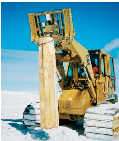
Figures 5a, b, c. Photos illustrant le remplacement du pilier de mesures absolues au cours de la campagne 2003-2004. L'ancien pilier, en bois, trop instable à cause du dessèchement du bois, a été remplacé par un pilier en polyéthylène enfoncé de 2,60m dans la glace. Trois étapes du remplacement sont illustrées : a) arrachement de l'ancien pilier, après enlèvement de l'abri ; b) mise en place du nouveau pilier ; c) repositionnement de l'abri, enfilé par-dessus le pilier qui passe à travers un trou ménagé dans le fond de l'abri.
